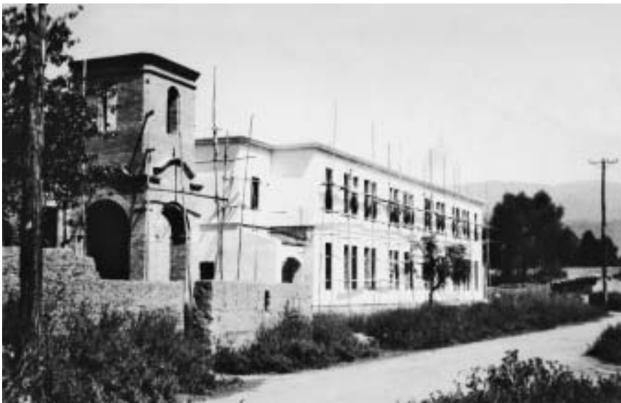
Colegio de la Tercera Orden Franciscana de Tarija en construcción.
